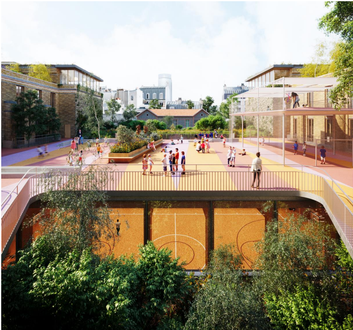
Gymnase implanté sous la cour, éclairé par des cours anglaise - © Chartier Dalix
